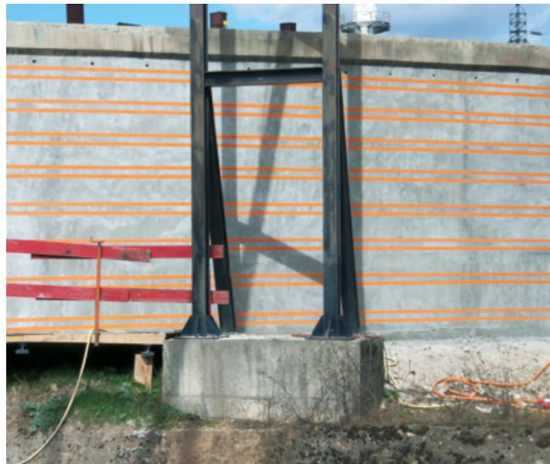
Préparation avant mise en place des lamelles Sika® Carbodur®
