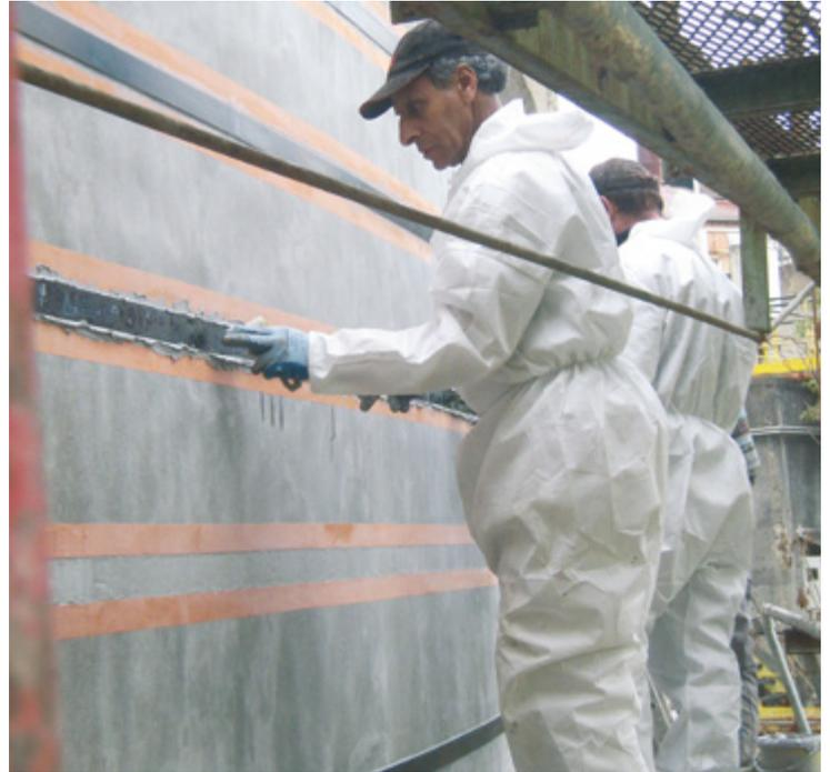
Préparation et mise en œuvre des renforts à base de fibres de carbone
