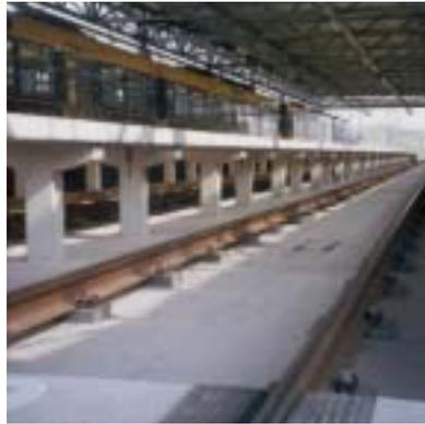
Remseck/Allemagne, Dépôt de véhicules rail légers. Semelles en acier collées avec Icosit® KC 340 sans goujons d'ancrage – un système très économique.
