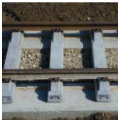
Stuttgart/Allemagne. Détail voie engazonnée type « Bremen » en construction.
