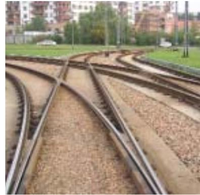
Cracowie/Pologne. Fixation discrète avec Icosit® KC 340 sur dalle en béton.
