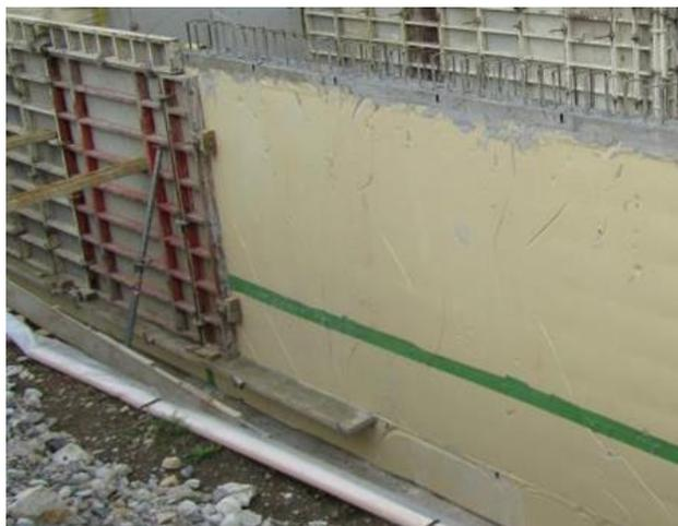
Il n'est pas nécessaire de mettre en œuvre des lignes de fixations intermédiaires. La membrane est maintenue sur son support par fixations mécaniques uniquement en tête au pas de 0,30 m minimum.
