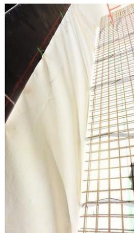
*Pose du géocomposite d'étanchéité SikaProof® A en radier*
