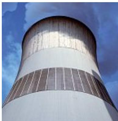
Afin de prolonger la durée de vie de l'ouvrage, il est possible d'effectuer des travaux d'entretien préventif (protection vis-à-vis de la pénétration de l'eau, des chlorures et du CO<sub>2</sub>,...) par exemple à l'aide des revêtements ou des hydrofuges techniques.
