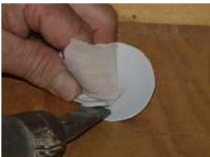
17. Chauffer l'angle à l'aide de l'appareil à air chaud, serrer avec la main et souder.
