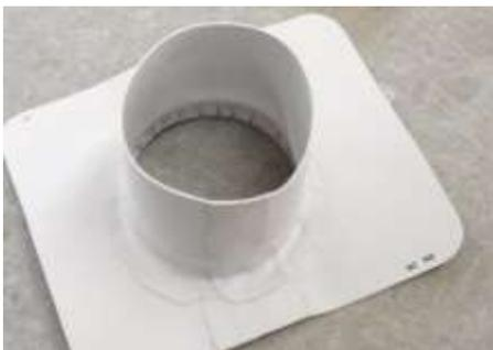
9. Souder le manteau à l'aide de l'appareil à air chaud.
