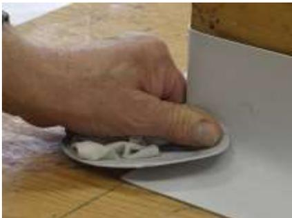
12. Souder la languette dressée verticalement vers l'arête de bas en haut sur la bande d'angle et presser manuellement.
