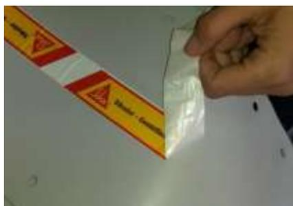
1. Enlever la bande adhésive centrale de la bande Sikadur-Combiflex SG type M ou SGT. Ceci permet d'éviter des défauts de soudure.
