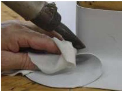
11. Fixer la rondelle ponctuellement à l'aide de l'appareil à air chaud.
