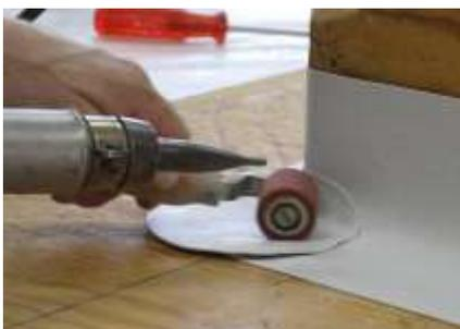
13. Fixer la zone de chevauchement horizontale des deux côtés puis souder à l'aide de l'appareil à air chaud et de la roulette de compression.
