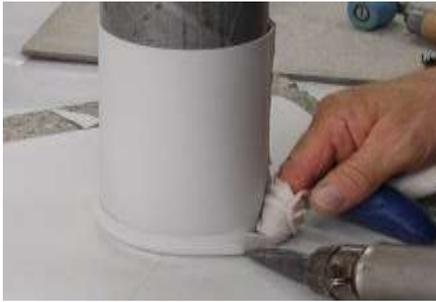
10. Souder au préalable le col en pressant avec les doigts sur la surface de raccordement et terminer la soudure à l'aide du rouleau de compression.
