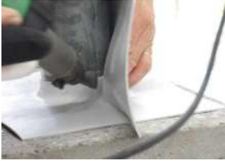
9. Souder la gaine dans le chevauchement à l'aide de l'appareil à air chaud et presser.
