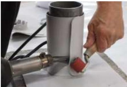
11. Fixer ponctuellement le bord de la gaine puis soudure préliminaire et soudure final de bas en haut.
