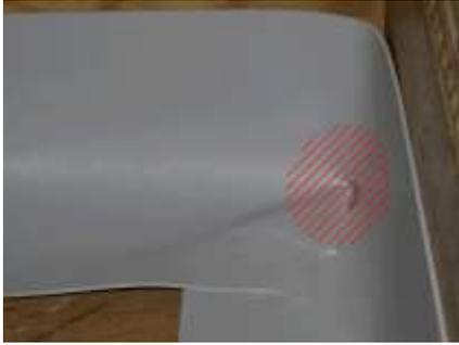
18. Poncer la surface de soudure (correspond à la rondelle formée) dans l'angle avec du papier abrasif.
