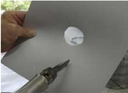
2. Chauffer la bande Sikadur-Combiflex SG ou SGT vers le trou à l'aide d'un appareil à air chaud.
