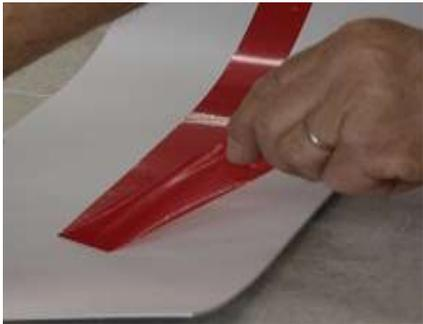
1. Enlever la bande adhésive centrale de la bande Sikadur-Combiflex SG type M ou SGT. Ceci permet d'éviter des défauts de soudure.
