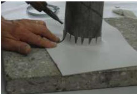
4. Chauffer le morceau de bande à l'aide d'un appareil à air chaud et donner la forme autour du tuyau.
