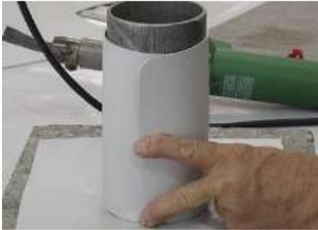
5. Découper un morceau de bande (largeur env. 15 cm) de sorte que la gaine du tuyau se chevauche sur env. 30 mm pour former le cordon de soudure.
