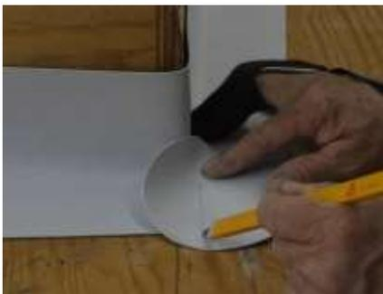
6. Poser la rondelle dans l'angle et dessiner les surfaces de soudure.
