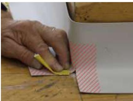
8. Poncer les surfaces de soudure de la pièce d'angle avec du papier abrasif.
