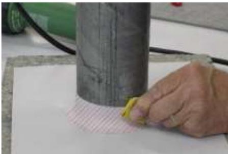
7. Poncer les surfaces de soudure sur la bande de raccord.
