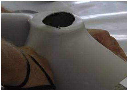
3. Chauffer et former la bande jusqu'à ce qu'il soit possible de coiffer le tuyau.
