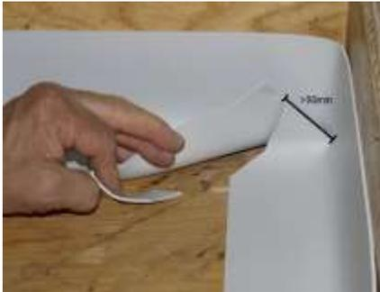
4. Pour faciliter la pose en cas de larges bandes, échancrer le pli dans le coin jusqu'à un maximum de 50 mm du bord de sorte qu'il reste une poche d'au moins 50 mm de longueur.
