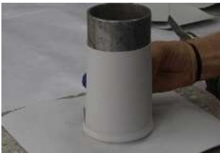
8. Chauffer et former régulièrement la gaine de raccordement à l'aide de l'appareil à air chaud.
