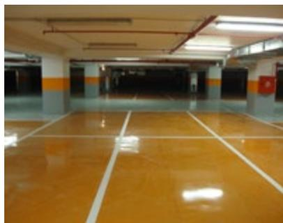
Le revêtement, dont le rôle est d'empêcher la pénétration de l'eau et des chlorures dans la construction en béton, doit en outre, pour les rampes d'accès, répondre à une exigence très élevée en matière de résistance à l'abrasion. D'autre part, la résistance optimale au cisaillement entre les différentes couches et au support est ici de la plus haute importance. Ce sont en partie des systèmes rigides et en partie des systèmes élastiques qui sont utilisés.
