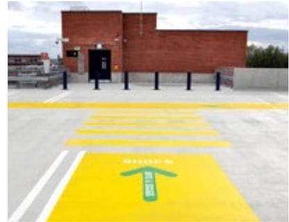
Les exigences envers les surfaces d'étanchéité et d'usure sur les planchers et les rampes extérieures sont particulièrement importantes. Elles doivent non seulement prévenir les infiltrations d'eau mais aussi résister à l'exposition mécanique provoquée par la circulation.
