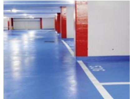
Les exigences envers les surfaces d'usure et d'étanchéité pour les zones exposées sont de prévenir d'autres détériorations sur les niveaux rénovés et d'offrir une solution durable pour prévenir les infiltrations d'eau et de chlorures dans les constructions neuves. Pour les niveaux intermédiaires des structures en béton armé, il peut être nécessaire d'utiliser un système de pontage des fissures à haute performance.
