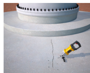
Percer des trous pour les injecteurs.
