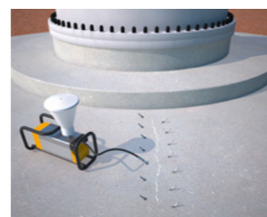
Appliquer la résine époxy à l'aide d'une pompe à injection.
