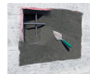
Appliquer le Sika MonoTop®-410 R en le serrant sur le support.
