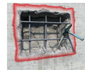
Retirer le béton abîmé et dégager les aciers.
