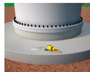
Préparation du support.
