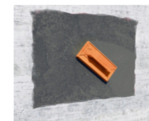
Finir à la taloche plastique, éponge ou polystyrène dès que le mortier commence à tirer.
