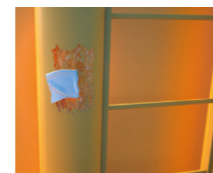
Nettoyage de la surface endommagée.
