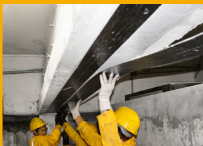
RÉNOVATION DU BÉTON
