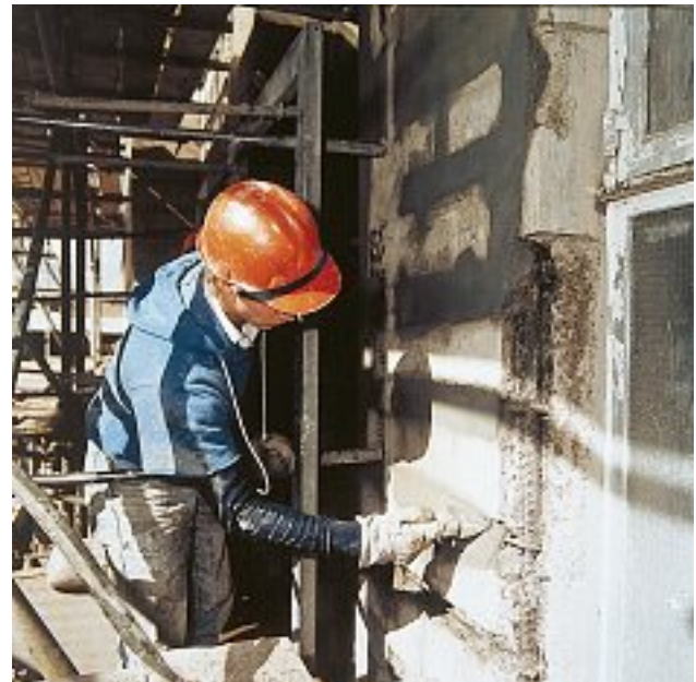
Photo 6 : Application du mortier de réparation léger en 1986
