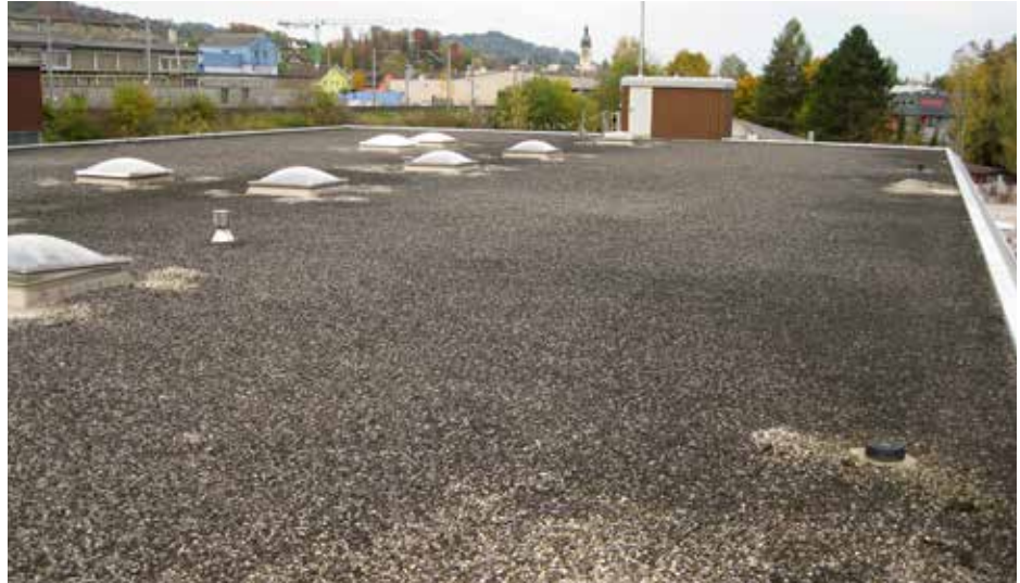
Fig. 4 : Fig. 4 : Vue d'ensemble du toit du bâtiment Brunner de Flawil (Suisse)
