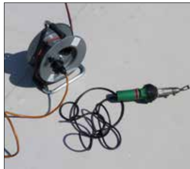
Fig. 6 : Thermosoudure d'une nouvelle membrane sur la membrane existante ( Sarnafil® TS 77-18 ) sur le toit du bâtiment Meusburger de Wolfurt (Autriche)
