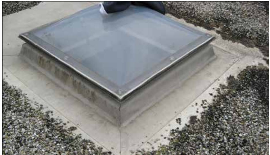
Fig. 5 : relevé d'un lanterneau sur le toit du bâtiment Brunner de Flawil (Suisse)
