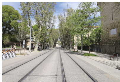
Voies de tramway
