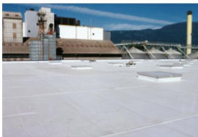
Cette technique ne nécessite pas la dépose de l'ancienne couverture et permet de poursuivre l'exploitation des locaux pendant toute la durée des travaux. Elle consiste à rapporter des panneaux d'isolant thermique afin de disposer d'un support plan sur lequel l'étanchéité est ensuite fixée mécaniquement.
