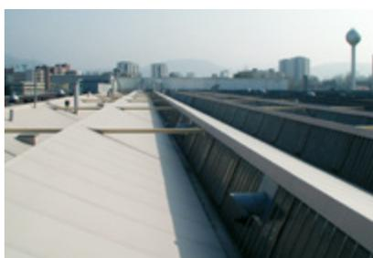
Système qui permet de fixer mécaniquement l'étanchéité par l'intermédiaire d'une ossature secondaire dans la structure porteuse, évitant ainsi toute fixation dans la couverture.
