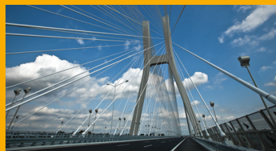
BÉTON D'INFRASTRUCTURE ET OUVRAGES D'ART
