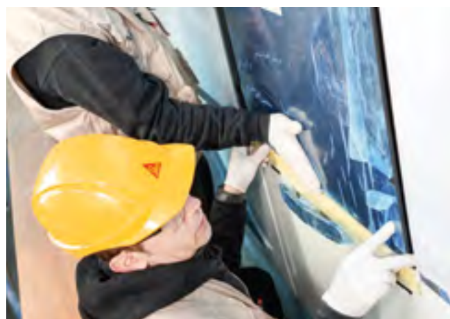
Mise en place du vitrage
