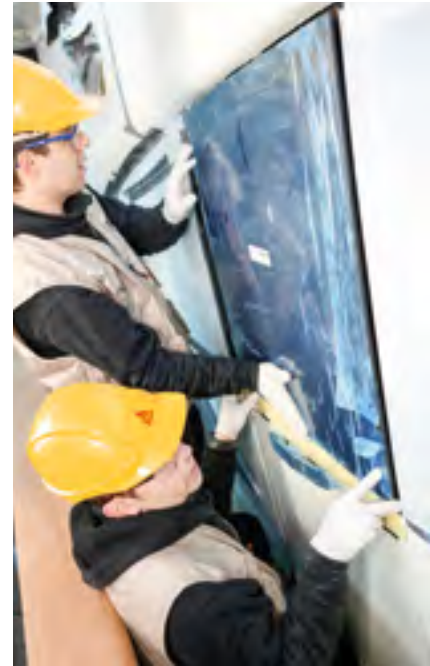
Mise en place du vitrage
