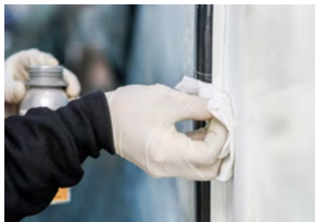
Préparation de la zone sérigraphie céramique avec Sika® Aktivator-100
