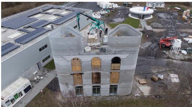
Dans ce cadre, La Tour est non seulement un exploit en termes de rapidité et de hauteur, mais représente surtout un modèle de durabilité et d'innovation. Ainsi, l'utilisation de l'impression 3D a permis de réduire considérablement les déchets de construction tout en optimisant les ressources et en réduisant l'empreinte carbone du projet : La Tour n'a pas nécessité l'utilisation de banches, ni
