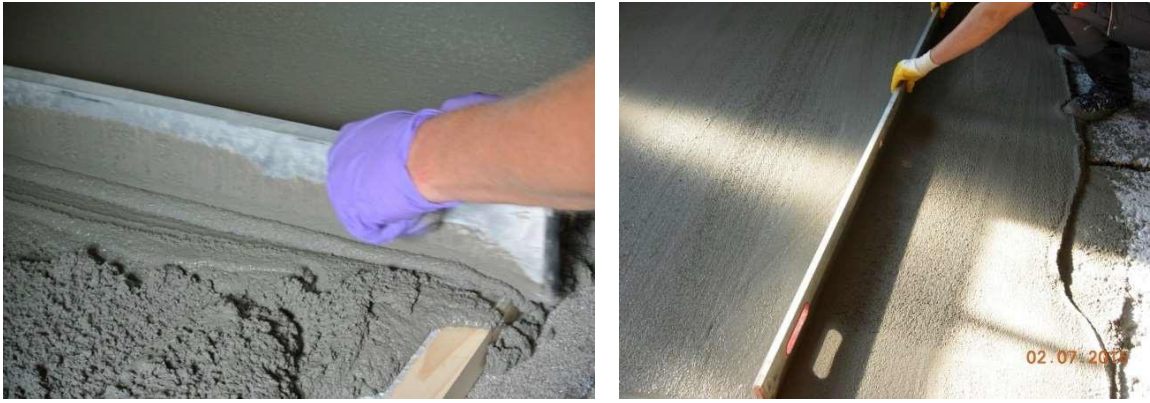
Figure 13 : nivellement à l'aide de poutres en bois et en acier
