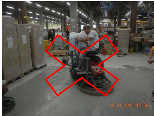
Figure 18 : truelle mécanique autoportée à ne pas utiliser
