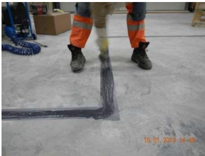
Figure 2 : scellement des joints
