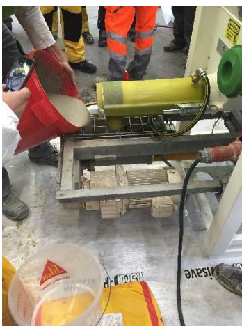
Figure 9 : ajout de SikaScreed®-10BB dans la pompe.
