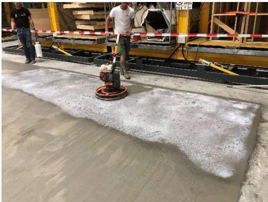
Figure 15 : lissage à la truelle mécanique après pulvérisation du Sikafloor®-140 Troweling Primer
