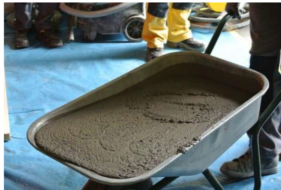
Figure 8 : transport du SikaScreed® HardTop
