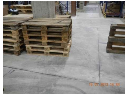
Figure 3 : joints après scellement
