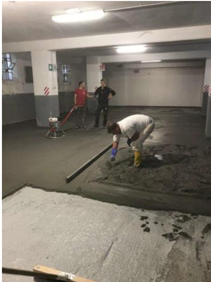
Figure 10 : application de la chape gâchée à 12 % d'eau
