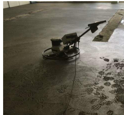
Figure 16 : lissage à la truelle mécanique
