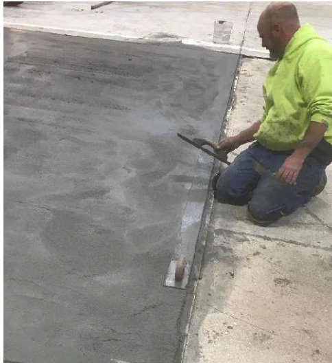
Figure 17 : travail de lissage sur les bords
