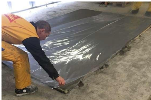
Figure 19 : application de la feuille de polyéthylène
