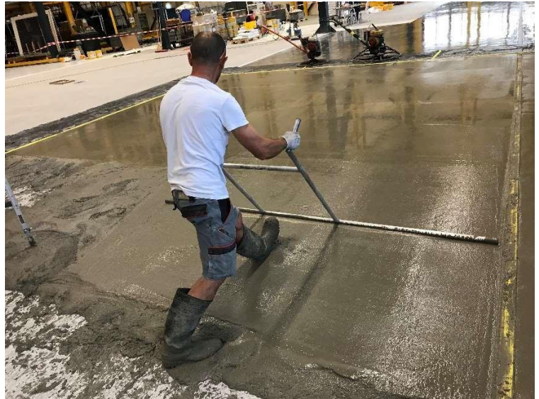
Figure 11 : utilisation de la barre de nivellement sur la chape gâchée à 15 % d'eau
