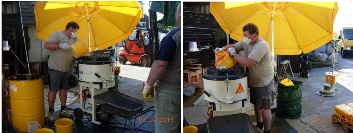
Figure 7 : mélange de SikaScreed® HardTop dans un malaxeur planétaire
