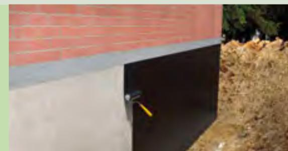
Émulsion bitumineuse gélifiée, imperméabilisation des fondations
