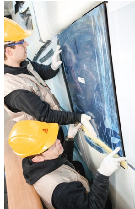
Mise en place du vitrage
