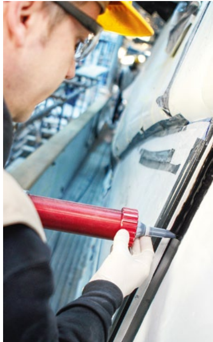
Application de la colle sur le cadre
