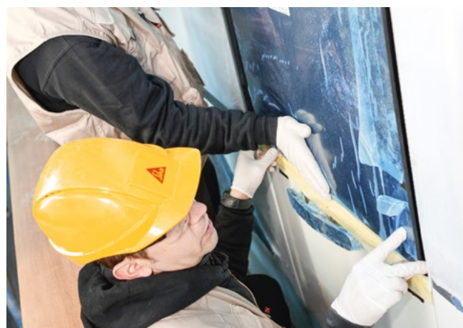
Mise en place du vitrage
