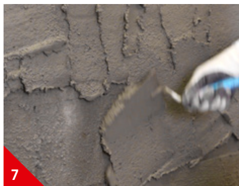
7 Appliquer à la truelle sur un gobetis humidifié
