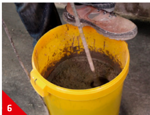
6 Mélanger 3 min à l'hélice 4 branches
