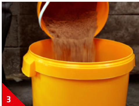
3 Verser 16 volumes de sable dans un seau (ex: 8 l)
