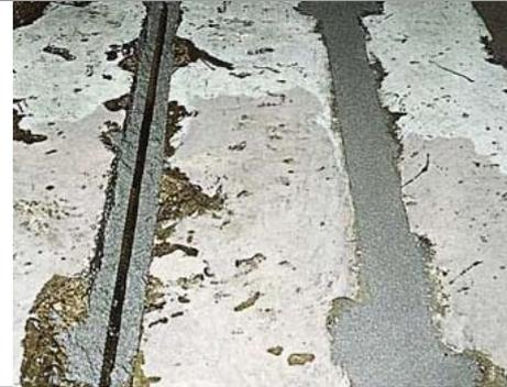
**Méthode 4.2** Ajout d'armatures scellées dans des trous pré-creusés ou forés NF EN 1504-6
