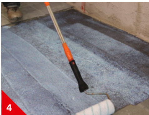
4 Appliquer en évitant les surcharges. Laisser sécher 1 h.
