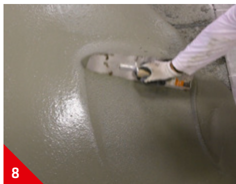
8 Étaler à la flamande (ou raclette d'étalement) sur le primaire
