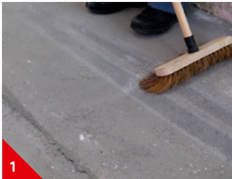
1 Dépoussiérer le support à l'aide d'un balai de cantonnier
