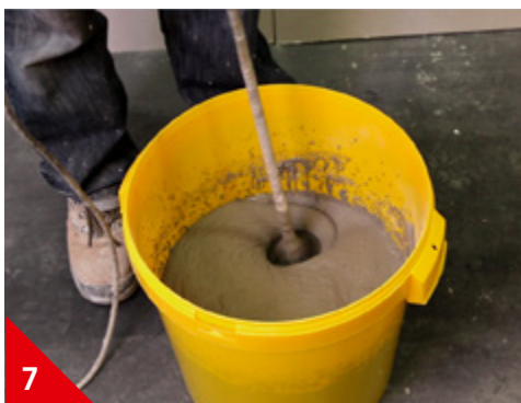
7 Malaxer avec une hélice 4 branches pendant 3 min.
