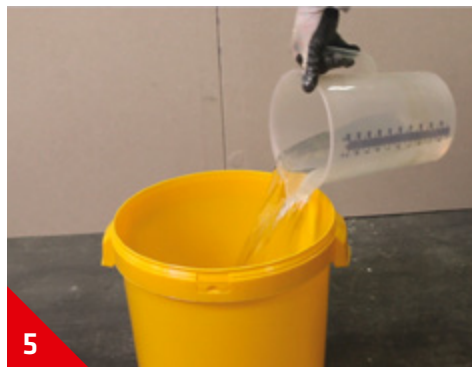
5 Verser l'eau (pour le Sika® Level-110 Extérieur) dans un seau (3,3 l / sac)
