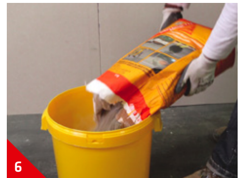
6 Ajouter le Sika® Level-110 Extérieur
