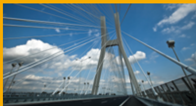
BÉTON D'INFRASTRUCTURE ET OUVRAGES D'ART
