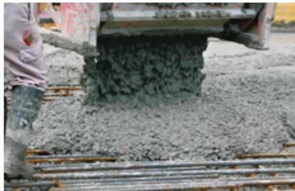
**Sika® ViscoCrete®** améliore la fluidité du béton en réduisant la teneur en eau grâce à son comportement d'absorption. La réduction de la teneur en eau augmente la densité et réduit la porosité dans la structure du ciment.
