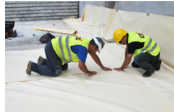
**SikaProof® A** est un système innovant de membrane en feuille entièrement collée pour l'étanchéité et l'imperméabilisation des sous-sols et des structures souterraines.
