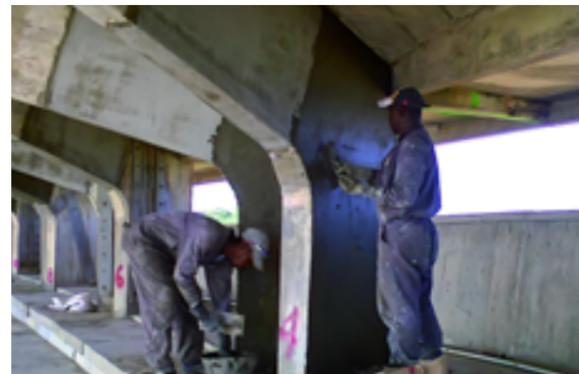
**Sika MonoTop® 4012** est un mortier monocomposant haute performance prêt à l'emploi, destiné à la réparation et à la protection du béton. Formulé dans une approche de développement durable, il contient des cendres volantes comme matériau cimentaire supplémentaire (SCM).
