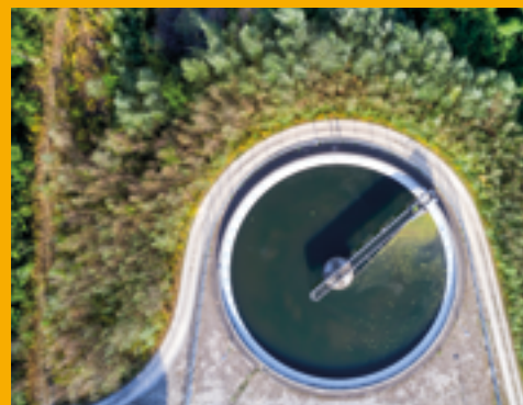
TRAITEMENT DES EAUX
