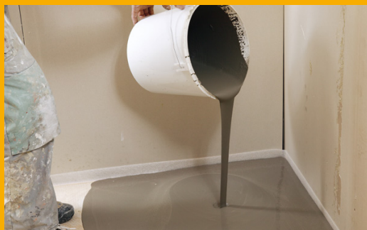
PRÉPARATION DES SUPPORTS
