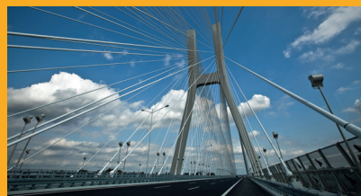
BÉTON D'INFRASTRUCTURE ET OUVRAGES D'ART
