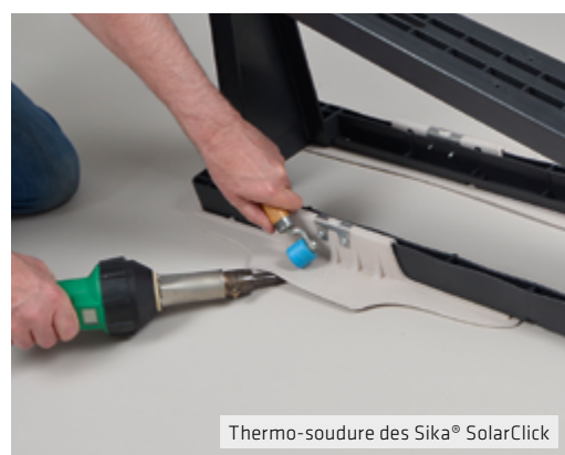
Montage en cours
