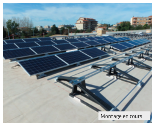
Préparation des composants du système sur un établi
