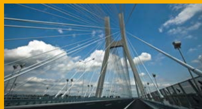
BÉTON D'INFRASTRUCTURE ET OUVRAGES D'ART
