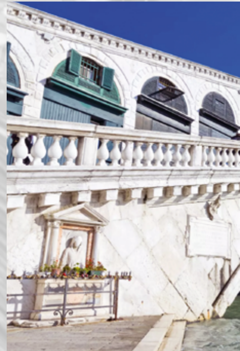
Pont Rialto, Italie SikaWrap® FX-50 C - SikaWrap®-300 C
