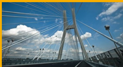
BÉTON D'INFRASTRUCTURE ET OUVRAGES D'ART
