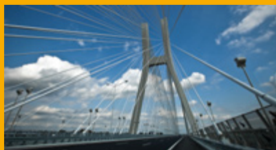
BÉTON D'INFRASTRUCTURE ET OUVRAGES D'ART
