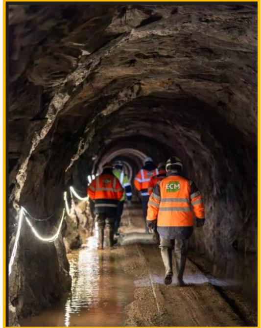
Après cela, les équipes ont pu procéder **au nettoyage du support**, à l'aide d'un nettoyeur haute pression de 500 bars. Une fois **le mortier gâché et versé dans la pompe in situ**, il a été **projeté par voie mouillée** sur tout le périmètre de la galerie, puis **taloché**, avant d'être recouvert par une **2<sup>nd</sup>e couche définitive**. L'épaisseur finale atteinte a été de 4cm en tenant compte des irrégularités de la surface du béton à traiter.
