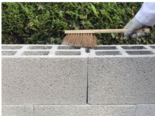
Dépoussiérage des blocs
