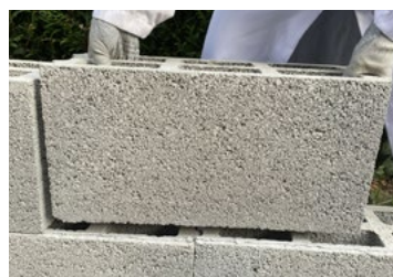
Assemblage des blocs
