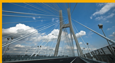
BÉTON D'INFRASTRUCTURE ET OUVRAGES D'ART
