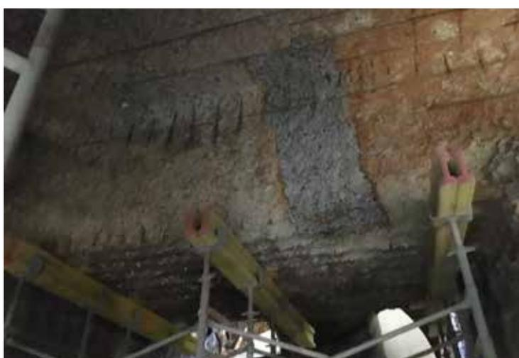
le coffrage. Lorsque le coffrage a été retiré, un jet d'eau à environ 150 bars a été utilisé pour exposer les agrégats afin de fournir une surface parfaite pour l'application du mortier de protection contre la corrosion biogénique.
