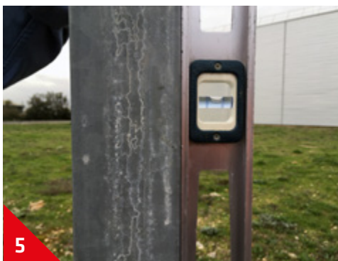
5 Lisser la surface et vérifier le niveau
