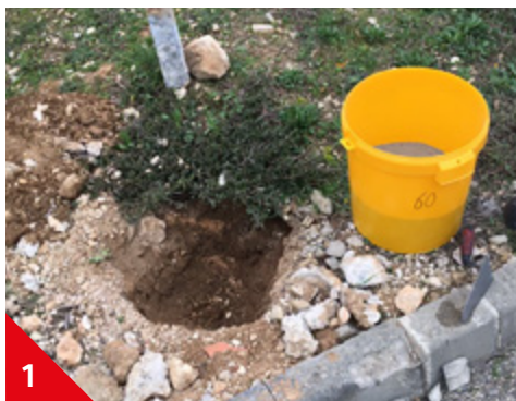
1 Creuser un trou Ex : 20 x 30 cm pour un poteau de clôture
