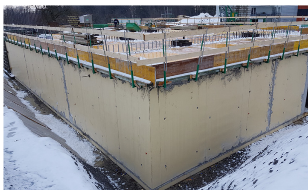
Fouille à ciel ouvert avec SikaProof® A+ : après dépose des coffrages, les trous de banche doivent être étanchés.
