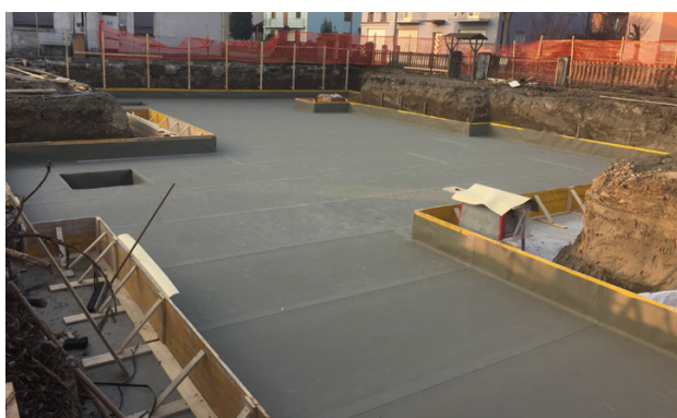
Application classique de SikaProof® A+ en radier.
