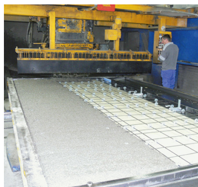
PRÉ-TRAITEMENT D'ÉLÉMENTS PRÉFABRIQUÉS
