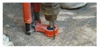
Percer dans le support des trous de 12 mm de diamètre et de 50 mm de profondeur espacés de 40 cm. La poussière générée est aspirée à la source.
