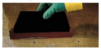
6 Noyer l'armature et les chevilles dans une couche de résine époxydique Sikafloor®-161 avec une raclette caoutchouc. Vérifier que les chevilles sont parfaitement remplies et que la trame est bien enrobée.
