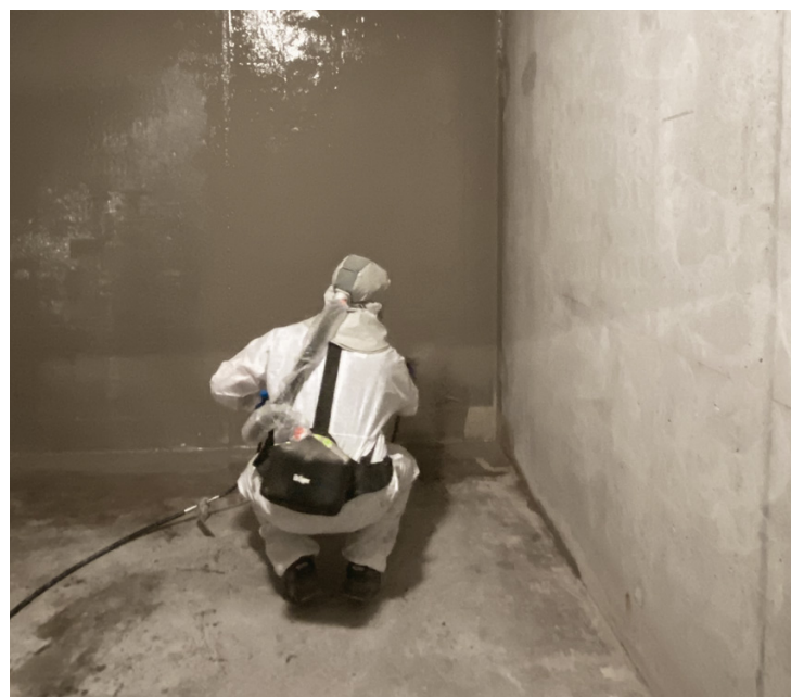
Mise en œuvre par projection
