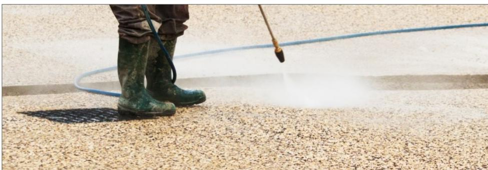
Dominant largement le marché du béton décoratif, le béton désactivé doit son succès à la liberté qu'il offre dans le choix des textures et des aspects, ainsi qu'à ses performances en matière de résistance et de durabilité, notamment face aux intempéries et au passage des véhicules.
