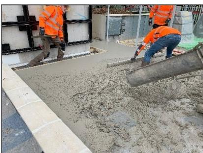
Composée de **six nouveaux produits**, la gamme de désactivants de surface pour béton SIKARUGASOL®, offre un choix entre **différents niveaux de désactivation, révélant les granulats du béton selon l'effet décoratif recherché** dans de nombreux aménagements extérieurs tels que les trottoirs, places publiques et pistes cyclables.
