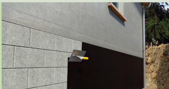
Revêtement bitumineux pour l'imperméabilisation des fondations en bloc de béton ou béton brut de décoffrage
