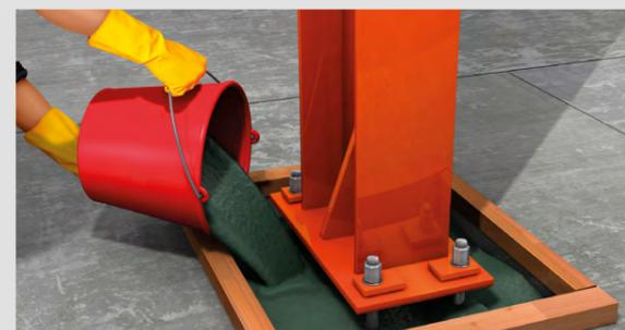
Micro-béton de scellement et calage pour gros volume
