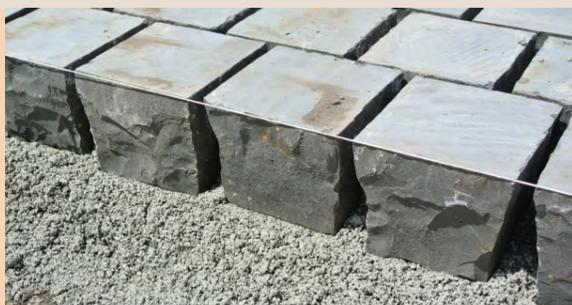
Mortier pour lit de pose de pavés et reprofilage de voies de circulation
