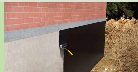
Émulsion bitumineuse gélifiée, imperméabilisation des fondations
