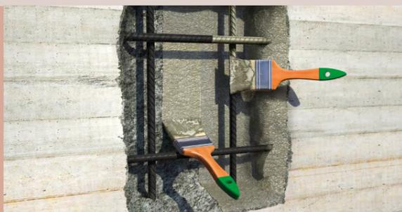
Coulis de protection anticorrosion des armatures du béton
