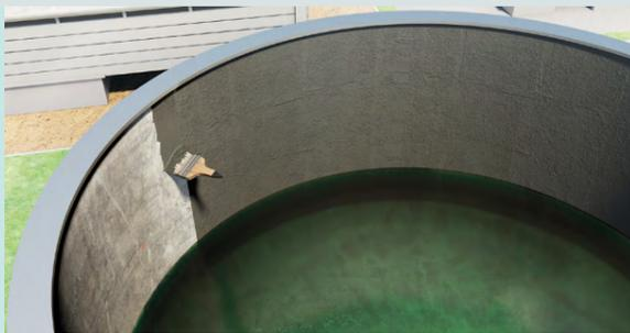
Revêtement d'imperméabilisation pour travaux de cuvelage
