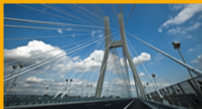
BÉTON D'INFRASTRUCTURE ET OUVRAGES D'ART
