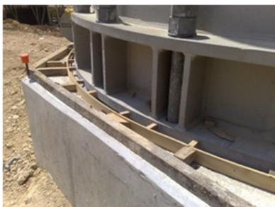
Le coffrage doit être propre et mis en place dès que possible après la préparation du support. Si nécessaire, des agents de démoulage peuvent être appliqués sur le coffrage avant la mise en place. Ne pas contaminer le support avec l'agent de démoulage qui pourrait réduire l'adhérence du coulis en raison d'un déversement ou d'un ruissellement.
