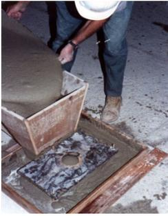
Cas d'une utilisation en calage : Continuez à verser jusqu'à ce que le coulis soit en haut de la plaque. Cela forcera le matériau à la face inférieure de la plaque et permettra d'obtenir une zone d'appui efficace sans aucun vide. Veillez à verser toujours le coulis des extrémités opposées dans les trous d'ouverture.
