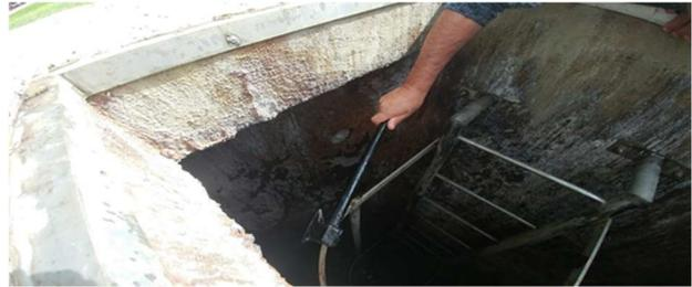
**Fig. 9 :** Photo prise en Israël, où un système similaire au scénario 2 a présenté une détérioration précoce, 5 ans après sa mise en œuvre.
