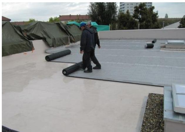
**Figure 4 - Mise en œuvre de la couche de drainage avec filtre intégré Sarnadrain-20**
