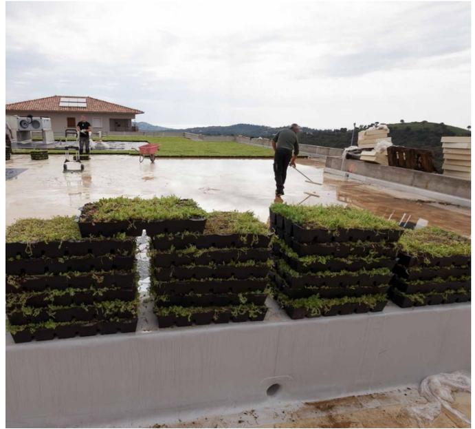
**Figure 5 - Mise en œuvre de cassettes Sarnapack**
