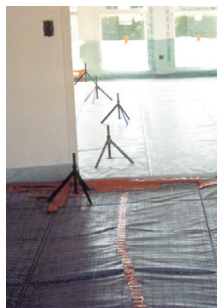
Joint au seuil de porte
