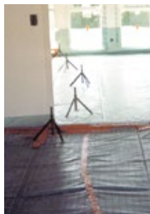
Joint au seuil de porte
